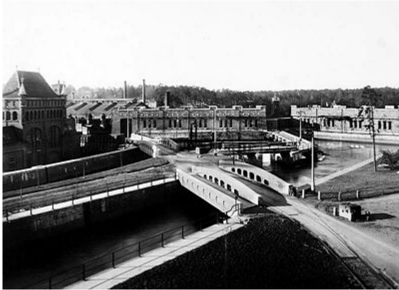
Kraftkanalen, Nohabs gamla industrier samt turbinintaget till Olidans kraftverk 1922. Bildkälla: Innovatum bildarkiv..
